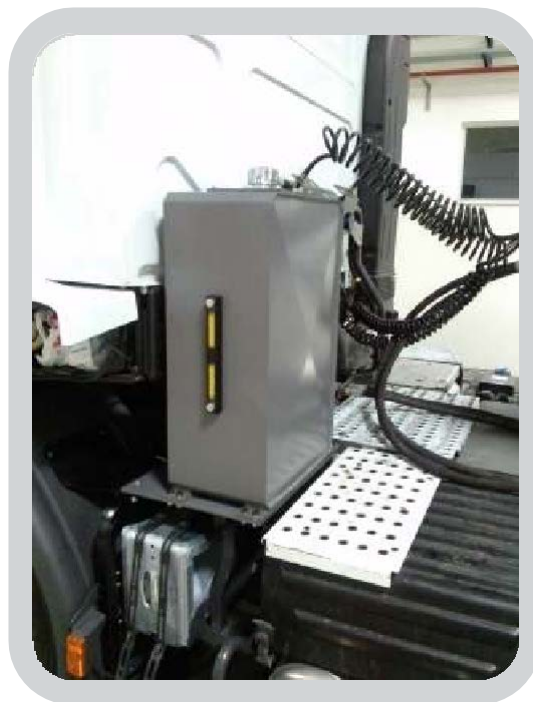
Маслобак, обеспечивающий работу гидравлической системы.
